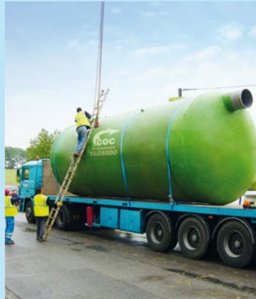
Déchargement du produit.
